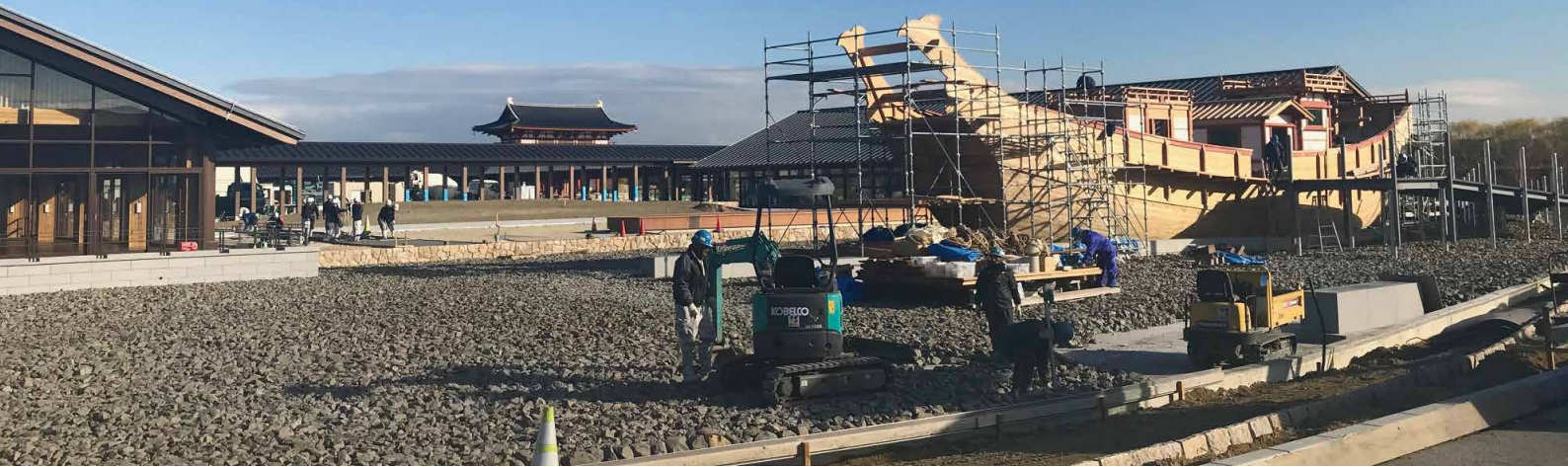
現在建設中の平城宮跡歴史公園内の「朱雀門ひろば」。平成30年3月24日オープン予定
