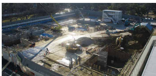
平成29年12月18日現在の工事状況
