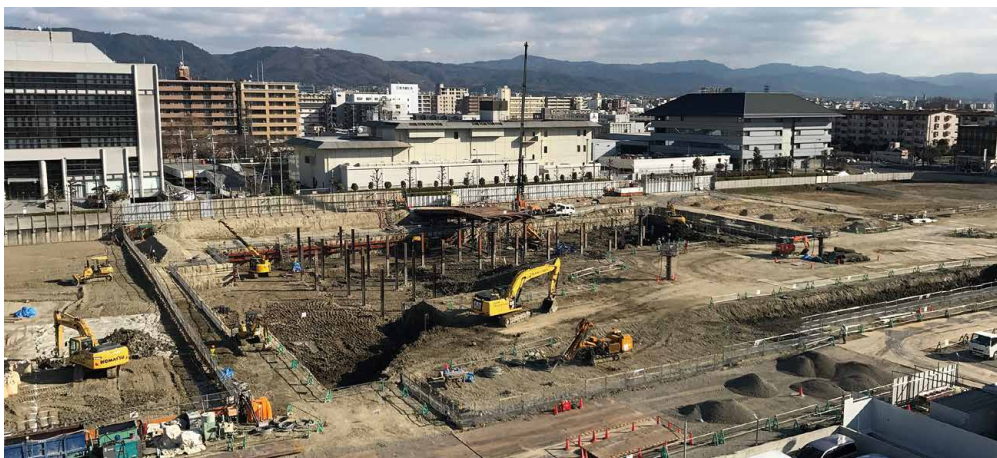
平成29年12月18日現在の交流拠点施設の工事状況
