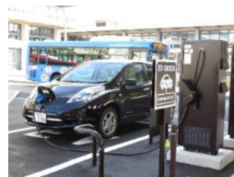
急速充電設備 (県本庁舎)
