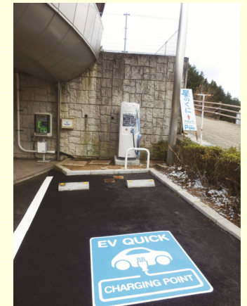
道の駅「吉野路大塔」へ導入された電気自動車用急速充電器
