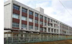
<耐震化の完了した校舎>
