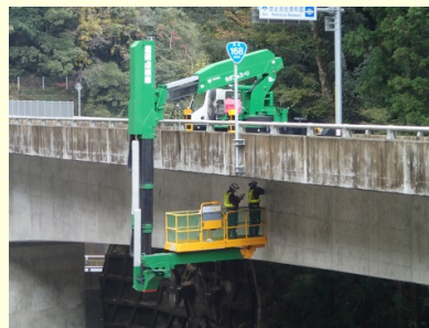
道路橋梁の点検
