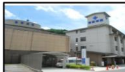
吉野病院（96床） ・国保吉野病院を改修 ・平成28(2016)年4月 リニューアルオープン
