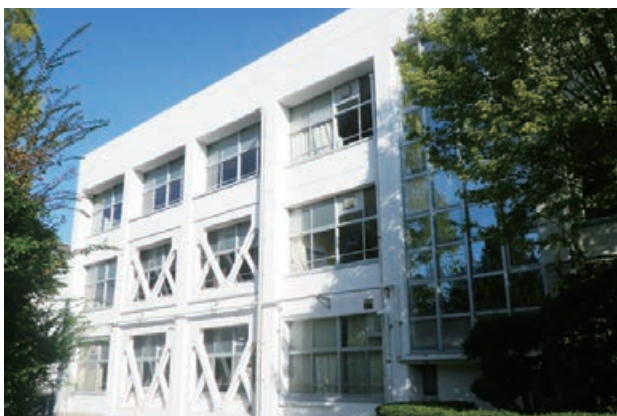
耐震改修工事(西の京高等学校)
