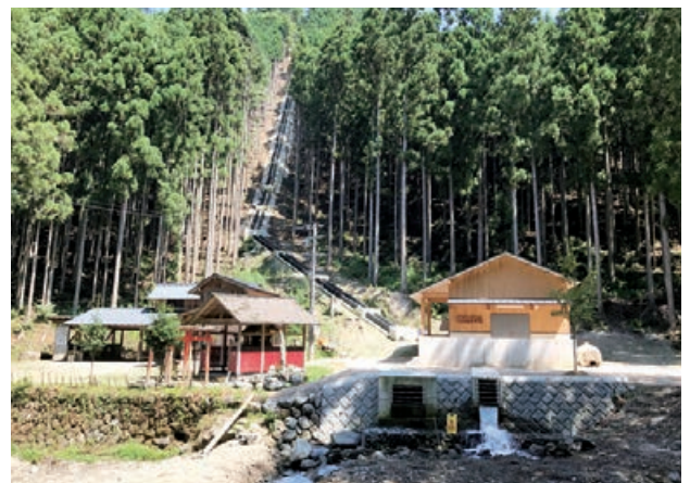
小水力発電機の導入(東吉野村・つくばね発電所)
