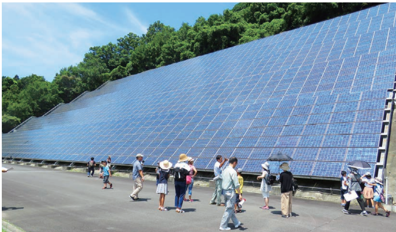
奈良県次世代エネルギーパークバスツアー(御所浄水場)
