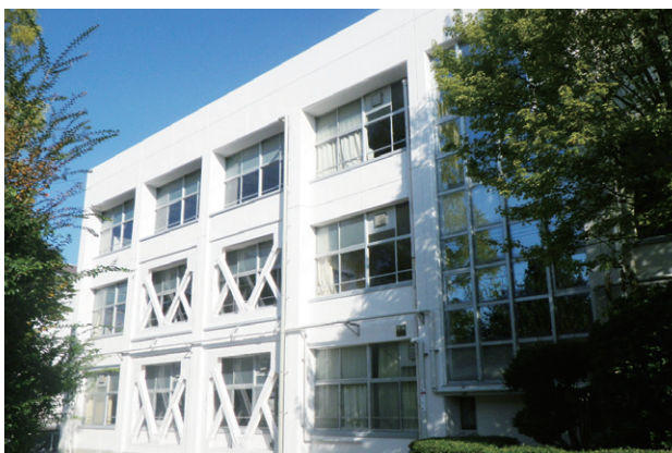
耐震改修工事(西の京高等学校)
