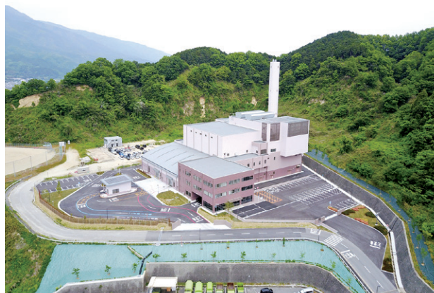
広域的なごみ処理を行う「やまとクリーンパーク」(御所市)
