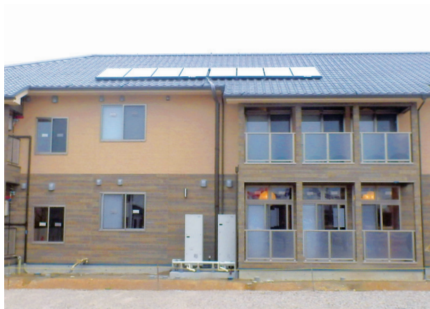
福祉施設における太陽熱温水システムの導入(桜井市)
