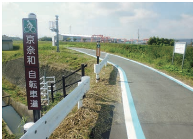
京奈和自転車道の整備(大和郡山市)
