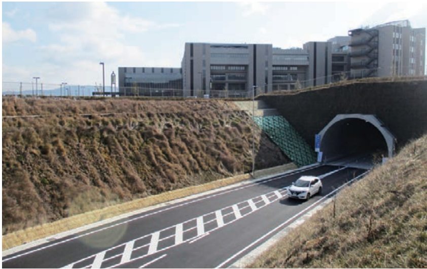
新奈良県総合医療センターへのアクセス道路 石木城線(大和郡山市)
