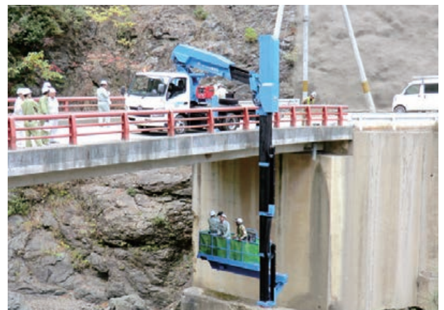
社会資本の長寿命化対策 橋りょう点検(野迫川村)
