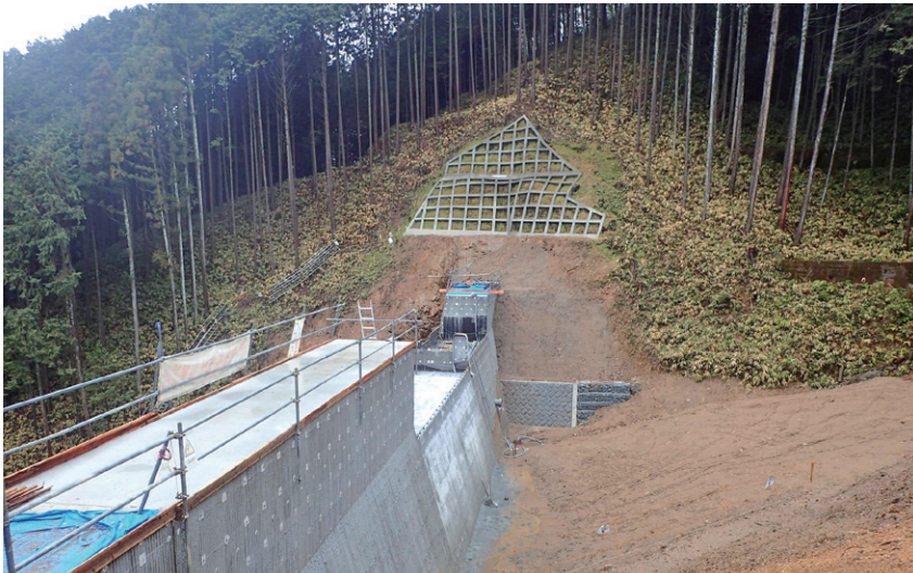
砂防対策工事の推進(天理市)
