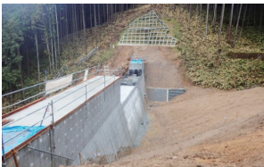
砂防対策工事の推進 (山田沢)(天理市)
