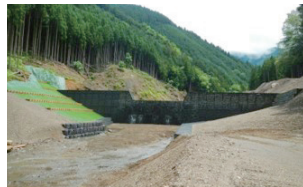
治山事業の推進 (川上村高原地区)
