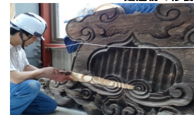
建造物の修復
