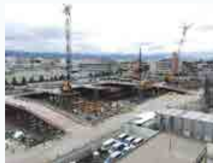
工事状況(平成30年6月中旬)
