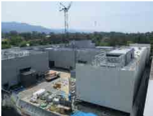
工事状況(平成30年7月末)
