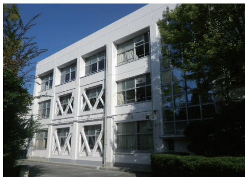
■県立高校の耐震補強例
