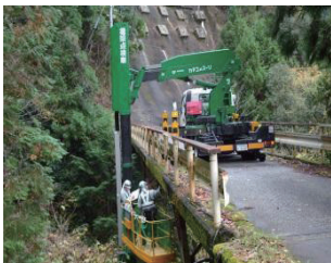
■橋梁点検車による近接点検
