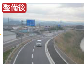
歩道の設置 交差点内 導流標示の設置
