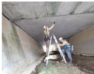
■打音検査による近接点検
