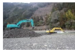
■神納川土砂撤去状況（十津川村）
