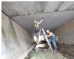
■打音検査による近接点検
