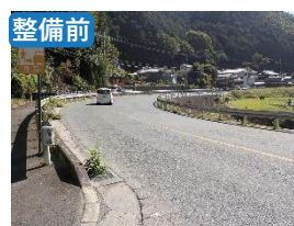
整備前 カーブ区間が連続しており、正面衝突・追抜追越時の事故が多発
