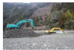
■神納川土砂撤去状況（十津川村）
