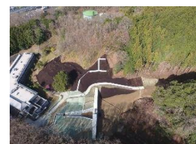
① 24時間利用の要配慮施設を保全する砂防施設(桜井市慈恩寺)
