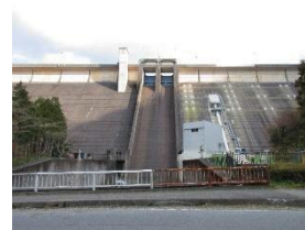
■新設洪水調節放流管が完成した天理ダム
