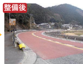
整備後 薄層舗装などの注意喚起により安全性が向上
