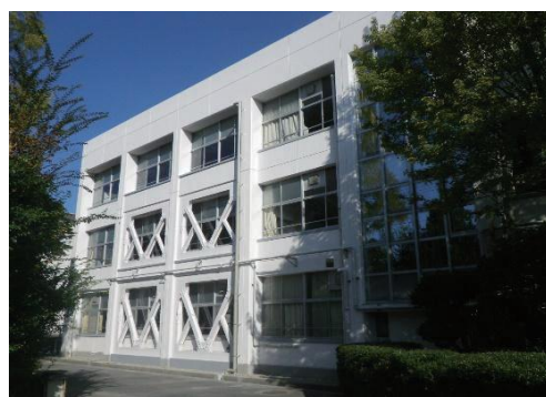
■県立高校の耐震補強例
