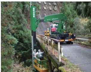
■橋梁点検車による近接点検
