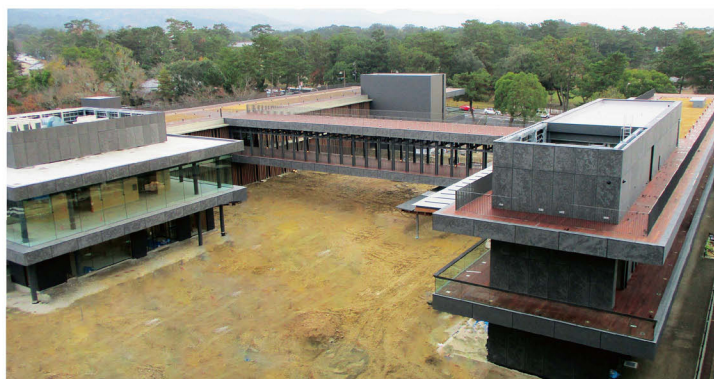
建設中の(仮称)登大路バスターミナル
