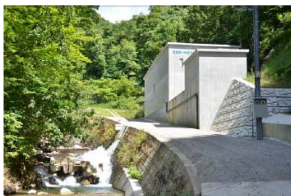
【菅沼第一水力発電所】
