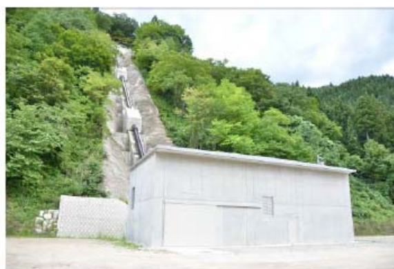
【菅沼第二水力発電所】
