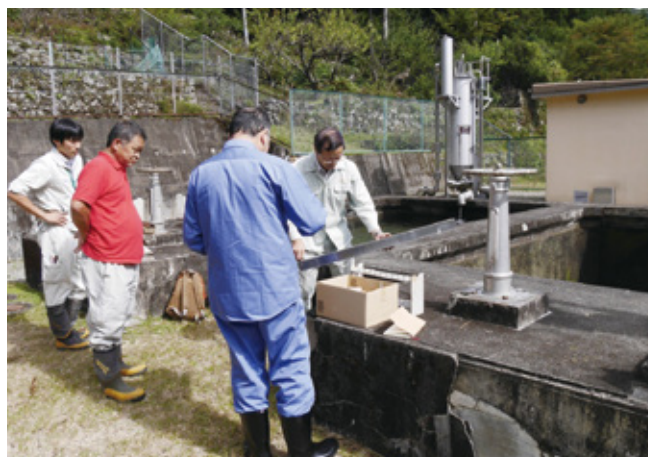
簡易水道の浄水処理への技術支援(上北山村西原地区)
