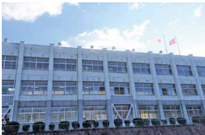
耐震改修工事(檀原高等学校)
