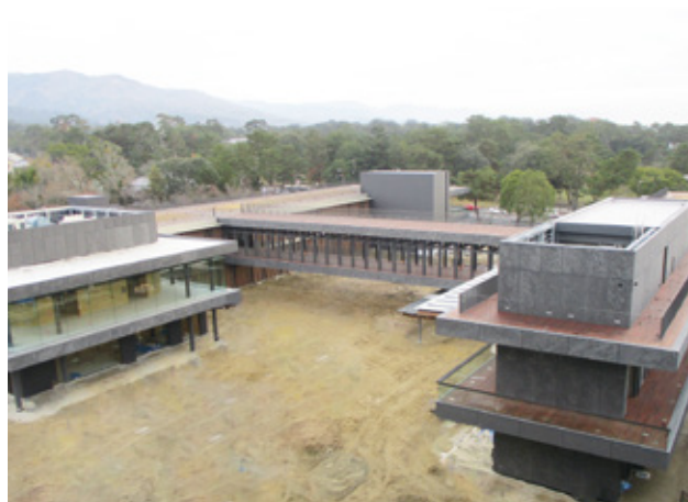
工事中の奈良公園バスターミナル(平成30年12月時点)(奈良市)
