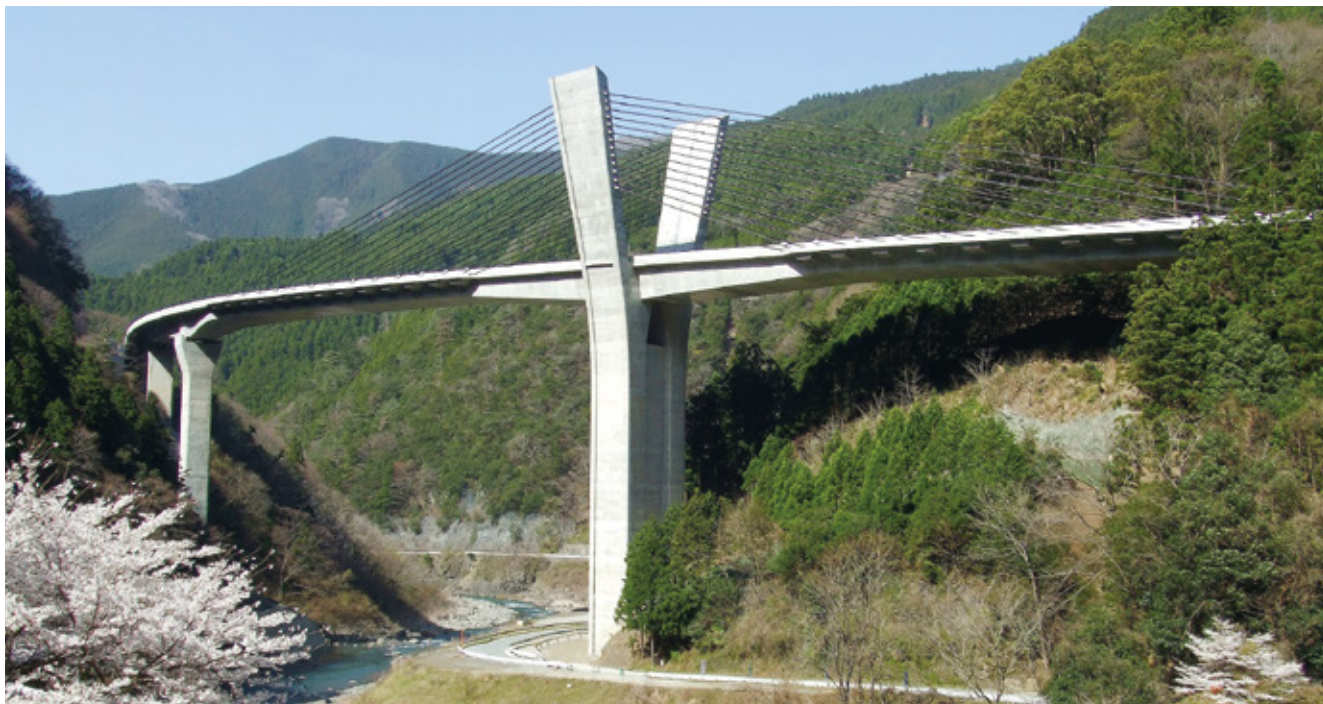
一般国道168号 辻堂バイパス 夢翔大橋(五條市)
