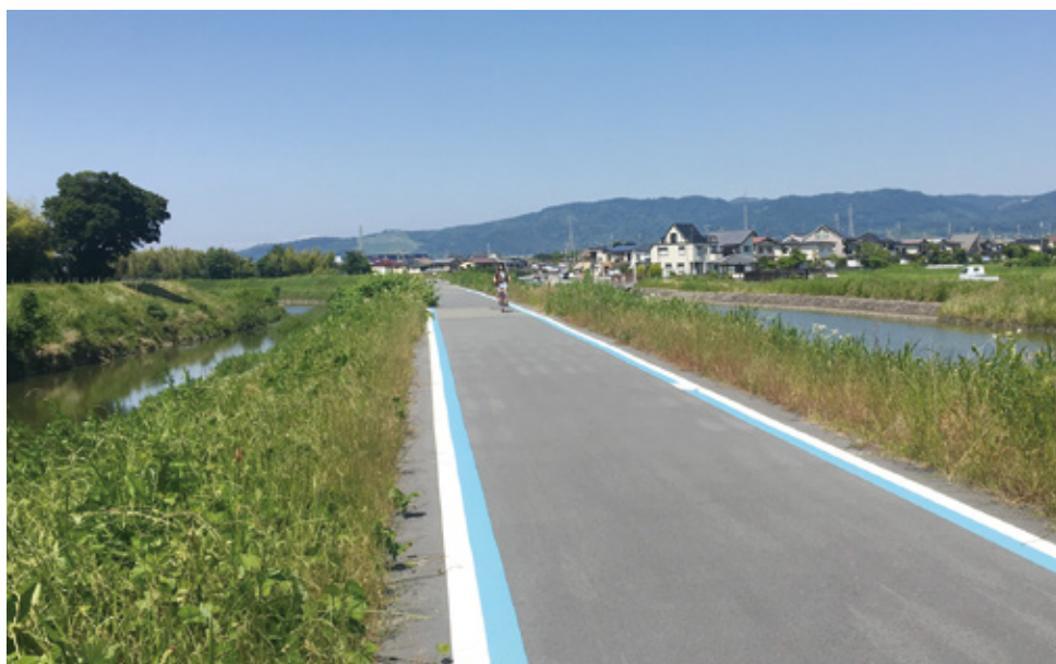
京奈和自転車道の整備(大和郡山市)
