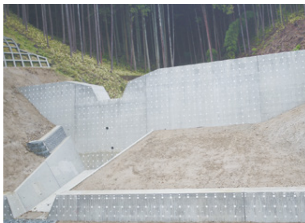
土石流対策工事(天理市)
