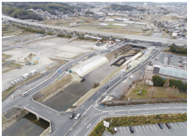
工事中の主要地方道枚方大和郡山線 中町工区(奈良市)
