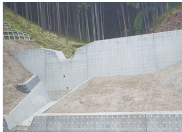
土石流対策工事(天理市)
