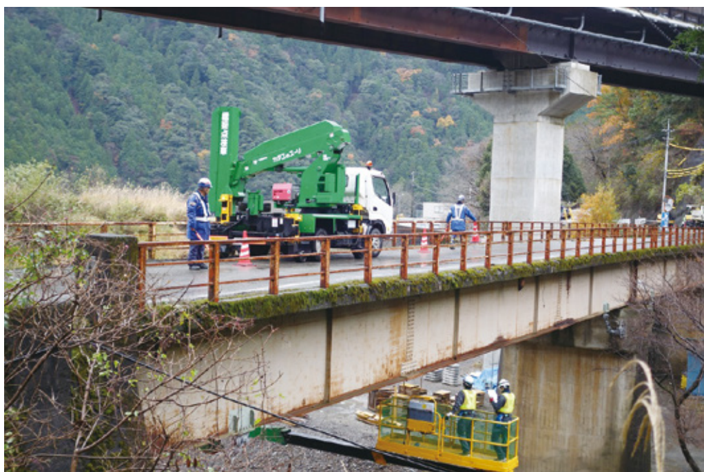
橋りょう点検・一般国道168号河津橋(十津川村)
