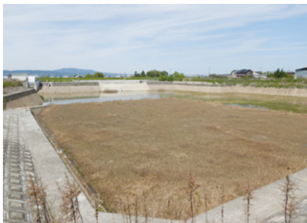
地蔵院川遊水地(奈良市)
