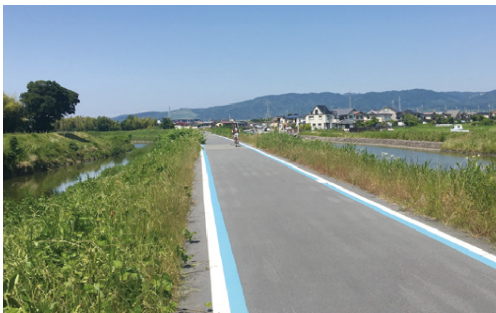
京奈和自転車道の整備(大和郡山市)
