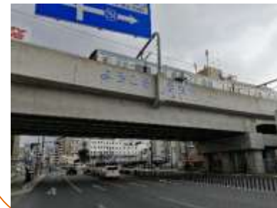
JR高架橋(西面)
