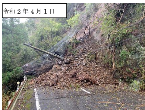
写真1 国道169号(下北山村内)崩土発生時
