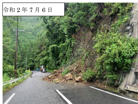
写真2 国道169号(上北山村内)崩土発生時
