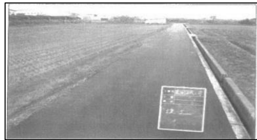
写真 2-2 農道整備（施工後）
