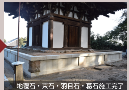
羽目石施工状況
