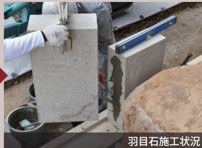
地覆石施工状況
