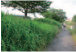
河川堤防の雑草による景観阻害 (大和高田市・高田川)
