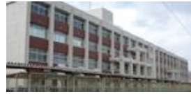
耐震化の完了した校舎
