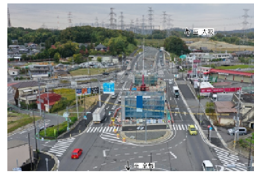
③高山高架橋(橋梁下部工事)
