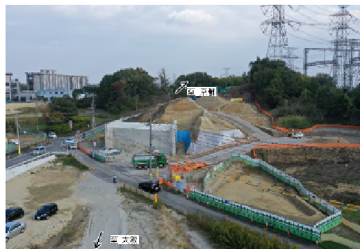
②北田原地区(土工事)
