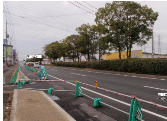
大和北道路(大和郡山市横田町)
