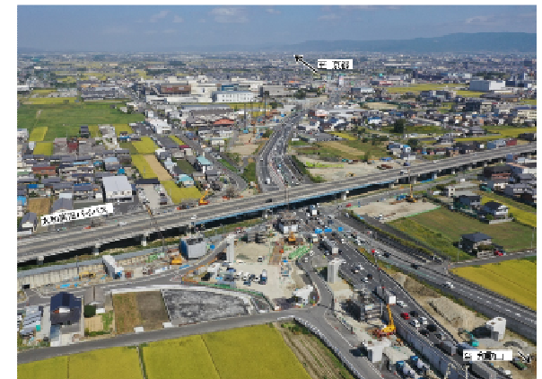
大和御所道路(橿原高田IC付近)
