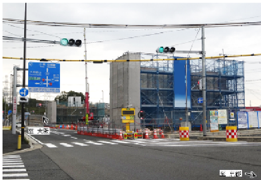
①高山高架橋(橋梁下部工事)
