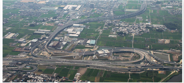
京奈和自動車道、西名阪自動車道周辺
