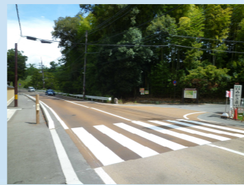
痛んだ舗装の補修
