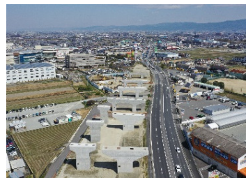
京奈和自動車道 橿原市新堂町本線部（橋梁下部工事）
