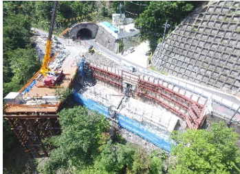
国道169号 川上村伯母谷～上北山村西原 （伯母峯峠道路 橋梁下部工事）
