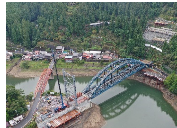
国道168号五條新宮道路 五條市大塔町阪本（阪本工区 橋梁上部工事）
