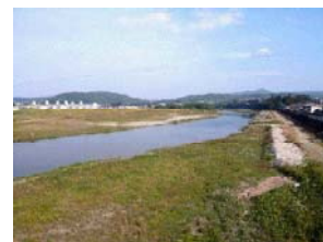
国道168号・大川橋
