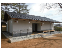
建替後の 五十二段北トイレ
