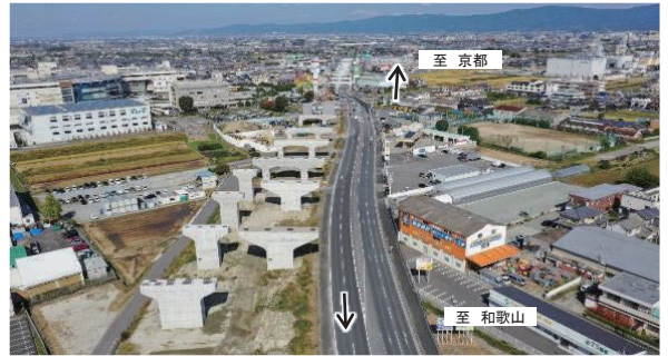
大和御所道路(橿原北IC～橿原高田IC)の工事状況
