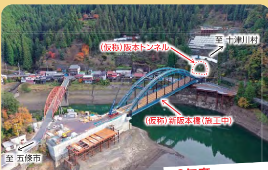
国道168号 阪本工区
