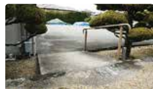
駐車場の脇のスロープ
