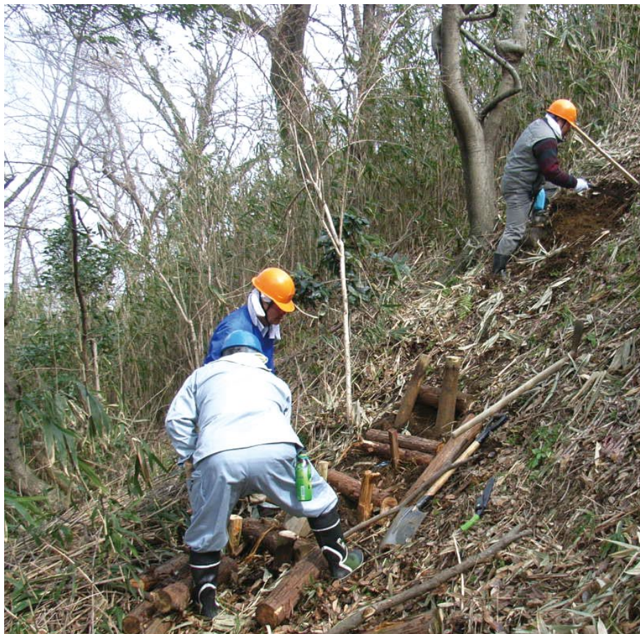
観察路に階段をつくる場合も、伐採した木を材料として使用
