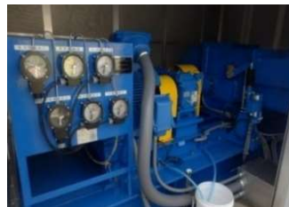
小水力発電設備の設置(御所浄水場)
