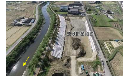
内水対策のため流域貯留施設を整備(王寺町)
