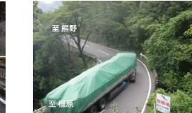
現道は急カーブが連続し線形不良であり車両のすれ違いが困難な状況
