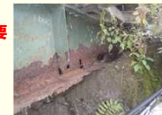
＜主桁腐食＞
