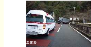
現道は急カーブが連続し線形不良であり車両のすれ違いが困難な状況
