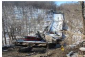
ファン・ホロー橋崩落（2022年） （国家運輸安全委員会（NTSB）HPより）
