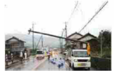
沿道の電柱の倒壊による道路閉塞
