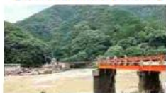
令和2年7月豪雨 熊本県道
