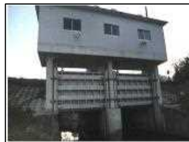
樋門 （小金打川逆流防止樋門）
