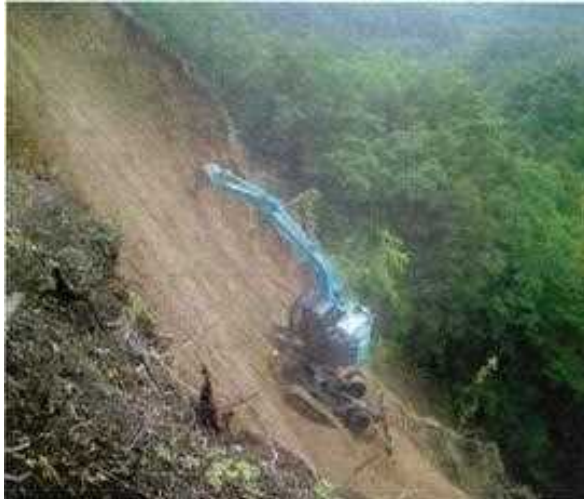
ロックライミング工法 による切土
