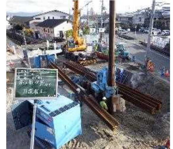
市街地施工で要騒音対策
