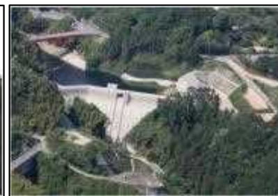
ダム （大門ダム）
