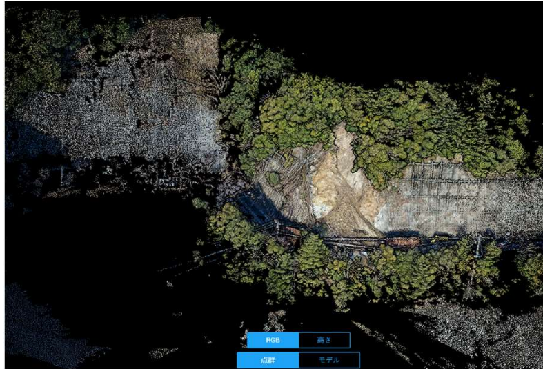
近隣斜面全景
