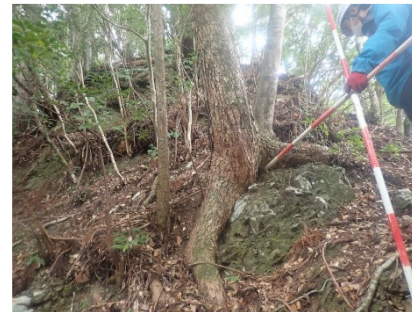
⑪斜面状況。泥岩露頭が点在
