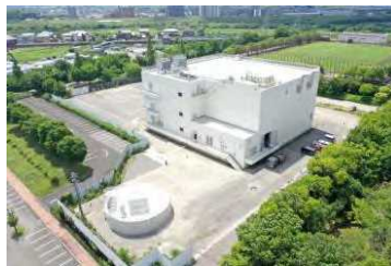
雨水ポンプ場
