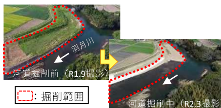
河道掘削(鹿児島県川内川水系羽月川)
