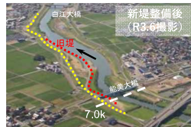
引堤(石川県梯川水系梯川)
