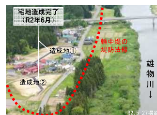
移転先宅地造成完了状況
