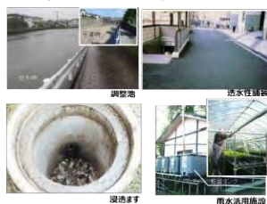
雨水貯留浸透施設の実例
