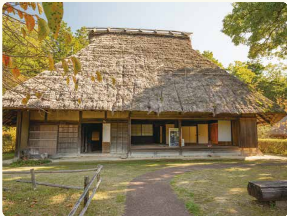
館外（大和民俗公園内）に県内各地から移築復元されている古民家9軒15棟のうち、3棟は国指定重要文化財、10棟が県指定有形文化財。写真の旧岩本家住宅（旧室生村・現在の宇陀市にあったもの）は、2023年に公開された映画「唄う六人の女」の撮影場所にもなった。土間まで入ることができる。
